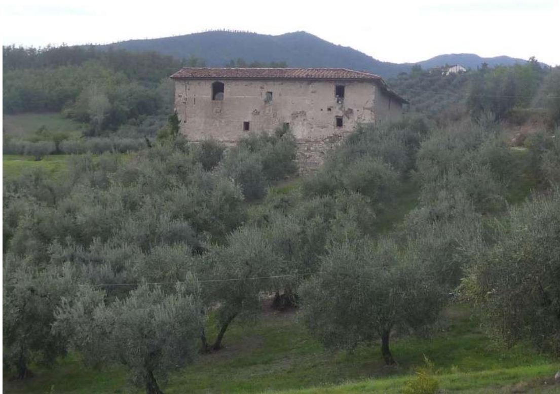
Foto 217: Terreni: oliveti e vigneti – vista casa colonica
