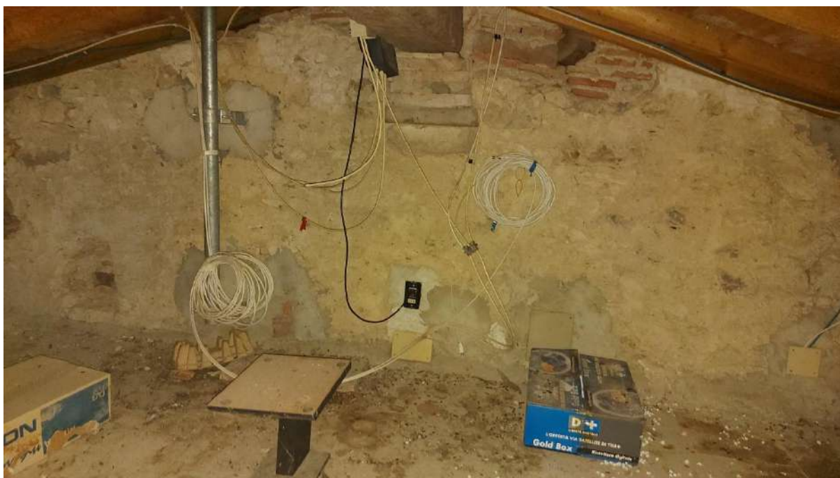
Foto 70: Villa – piano 2° - soffitta
