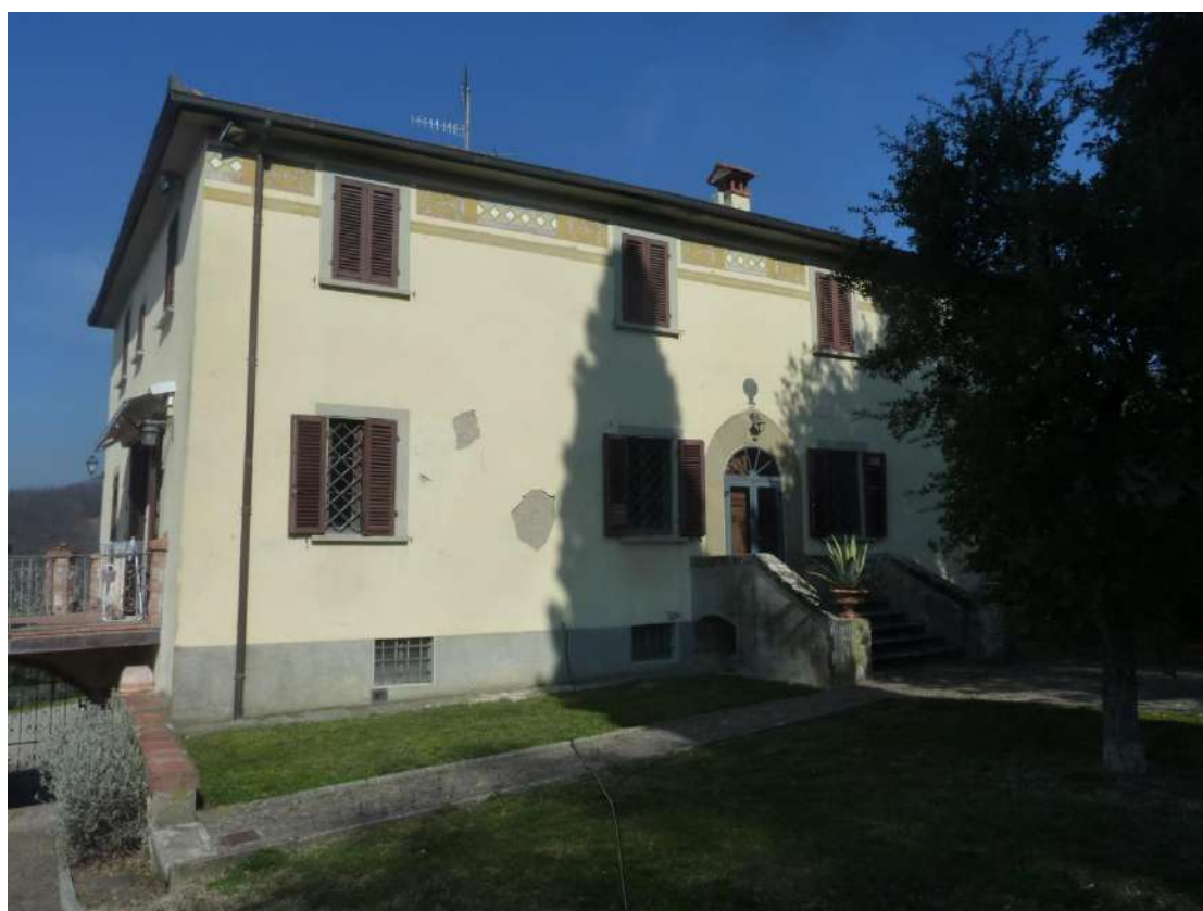
Foto 26: Villa – accesso laterale al piano terra rialzato
