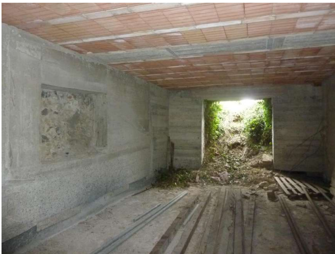
Foto 28: Casa colonica – piano seminterrato – cantina
