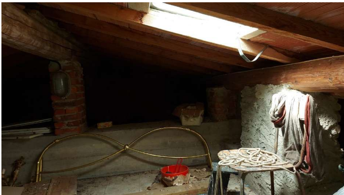
Foto 71: Villa – piano 2° - lucernario soffitta
