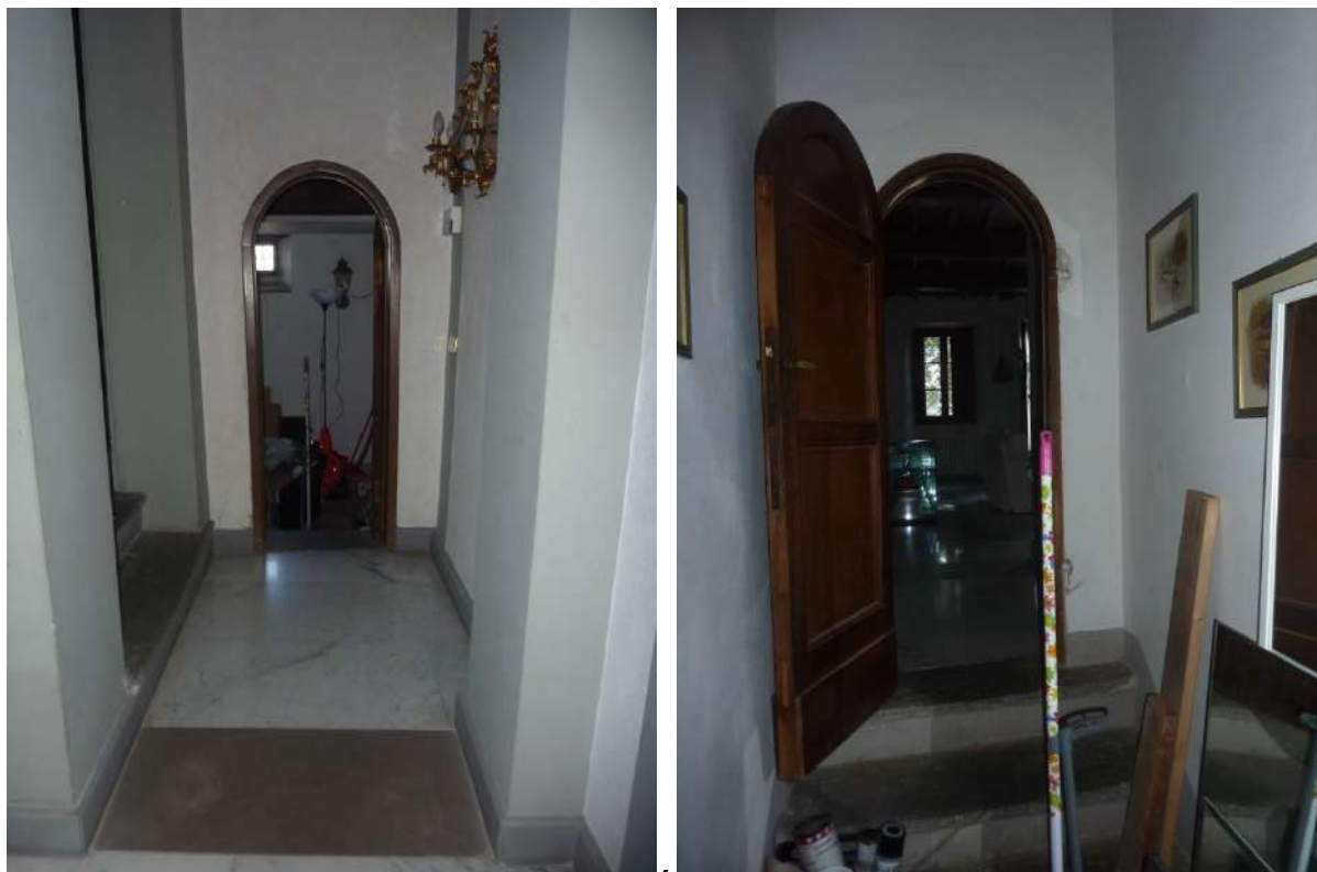
Foto 119: Villa – piano terra – comunicazione tra ingresso centrale e scala B
