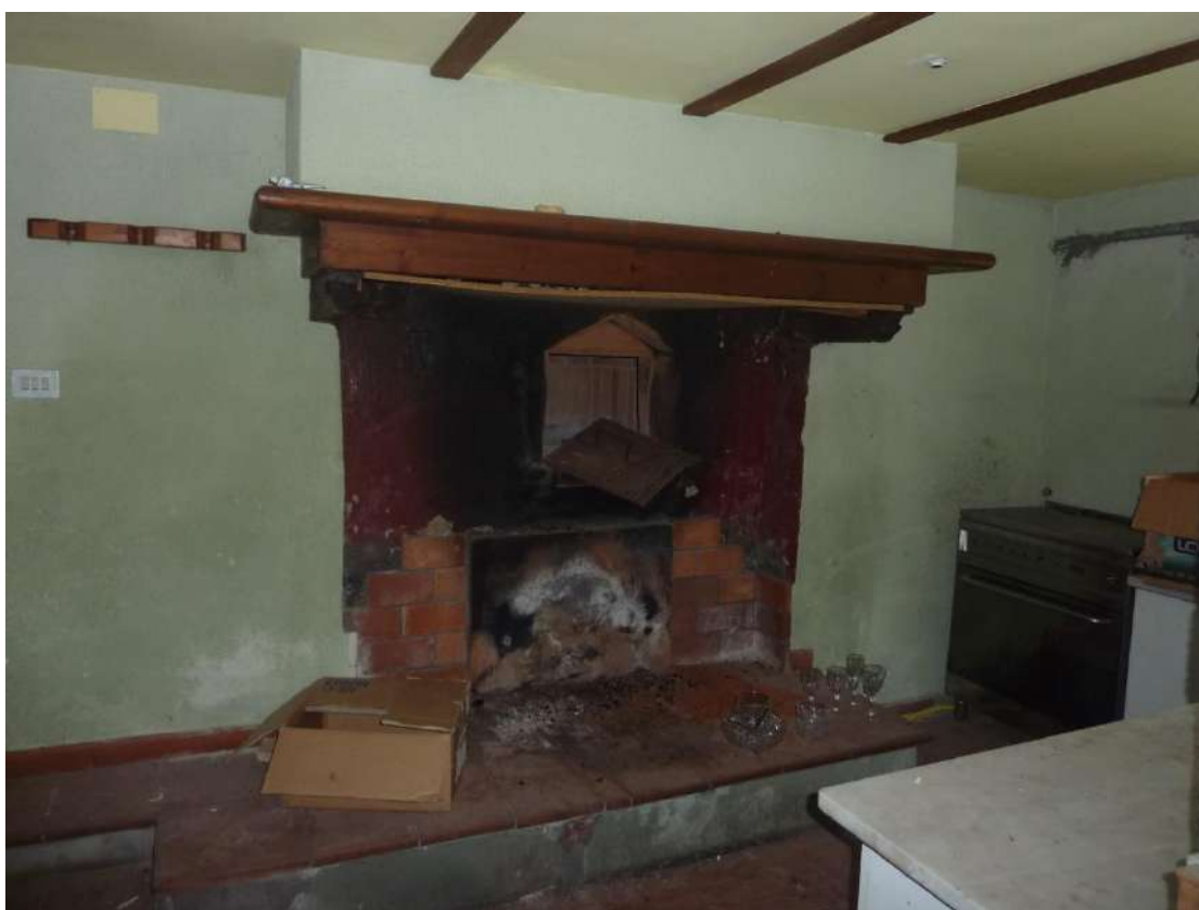
Foto 40: Casa colonica – piano terra – cucina – caminetto e forno a legna
