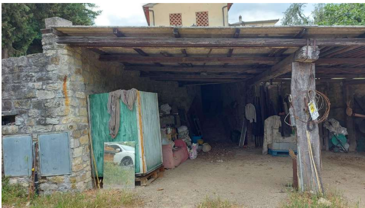
Foto 64: Tettoia – accesso alla cantina della dépendance
