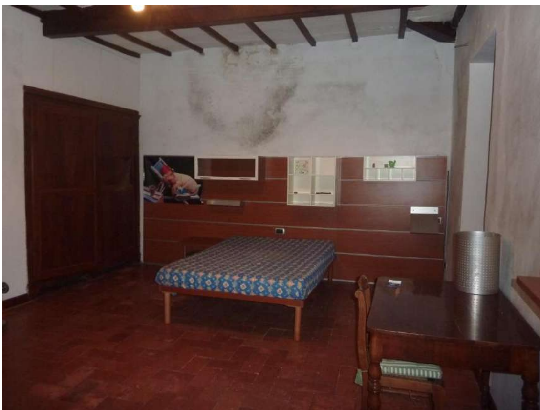
Foto 84: Villa – piano 1° - camera tergale d'angolo (Est)
