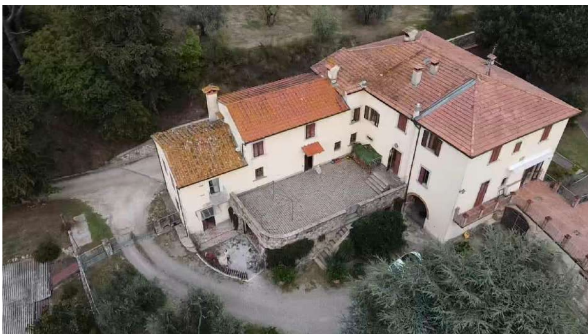
Foto 10: vista drone - villa/dépendance
