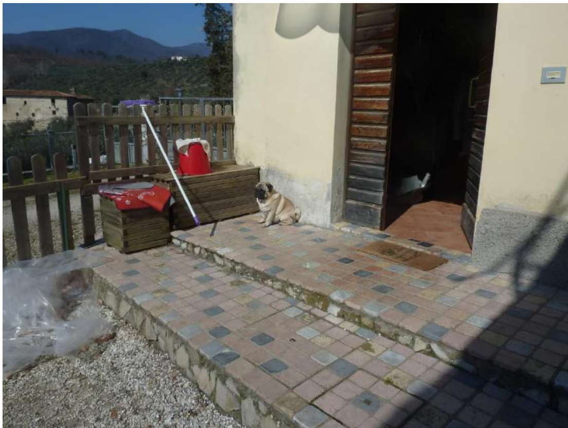
Foto 175: Dépendance – piano seminterrato 1° – accesso all’abitazione
