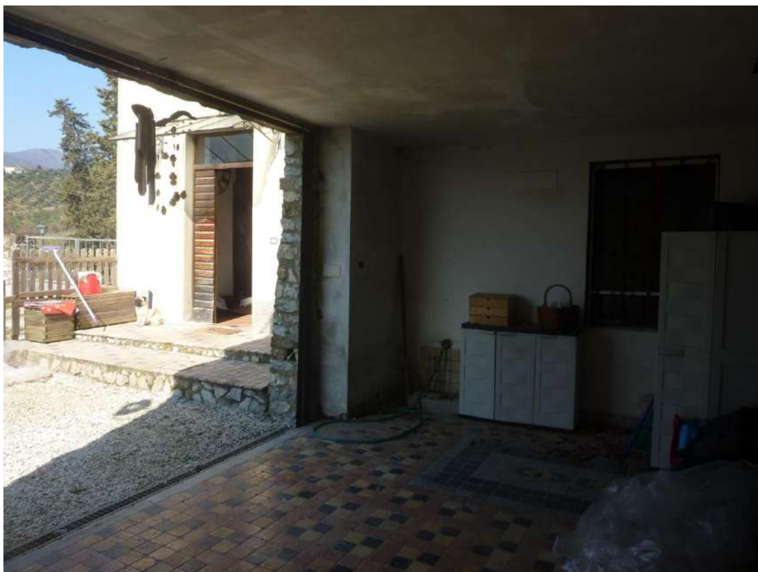
Foto 191: Dépendance – piano seminterrato 1° – loggia
