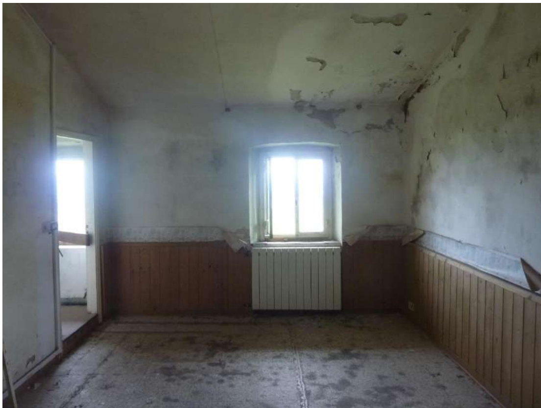
Foto 35: Casa colonica – piano primo – camera Nord
