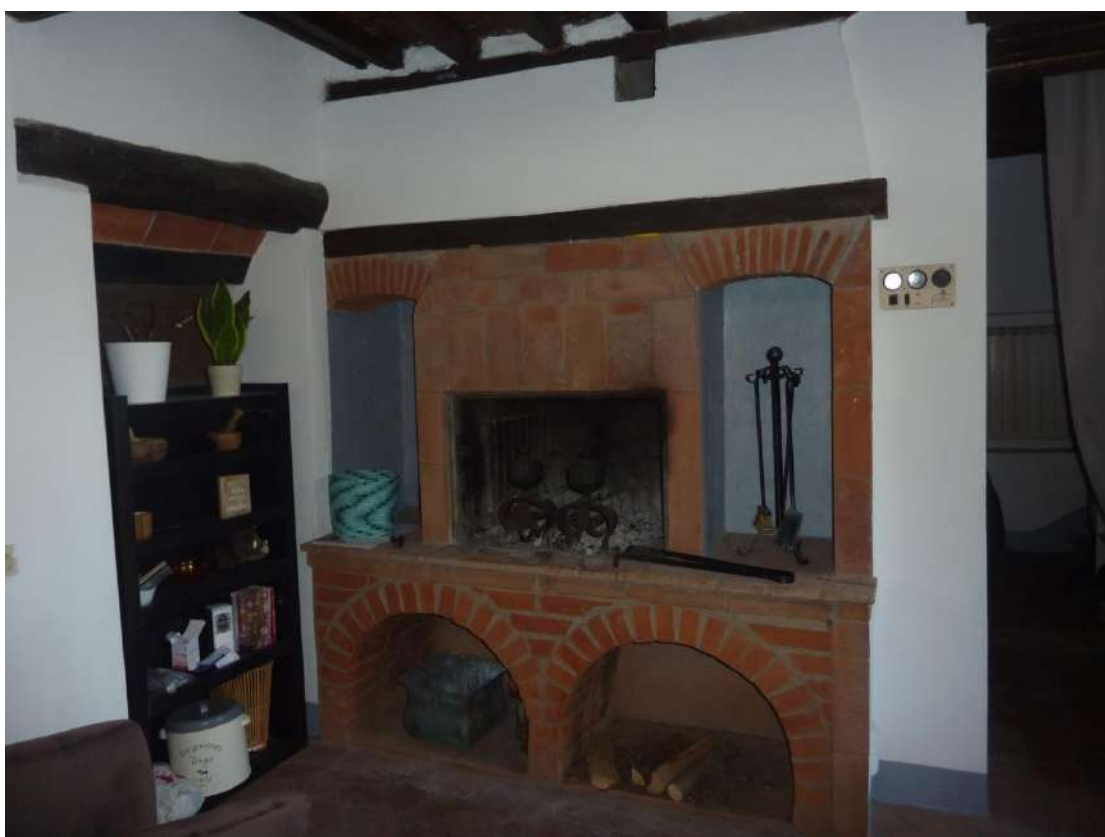
Foto 162: Dépendance – piano terra – soggiorno – termocamino
