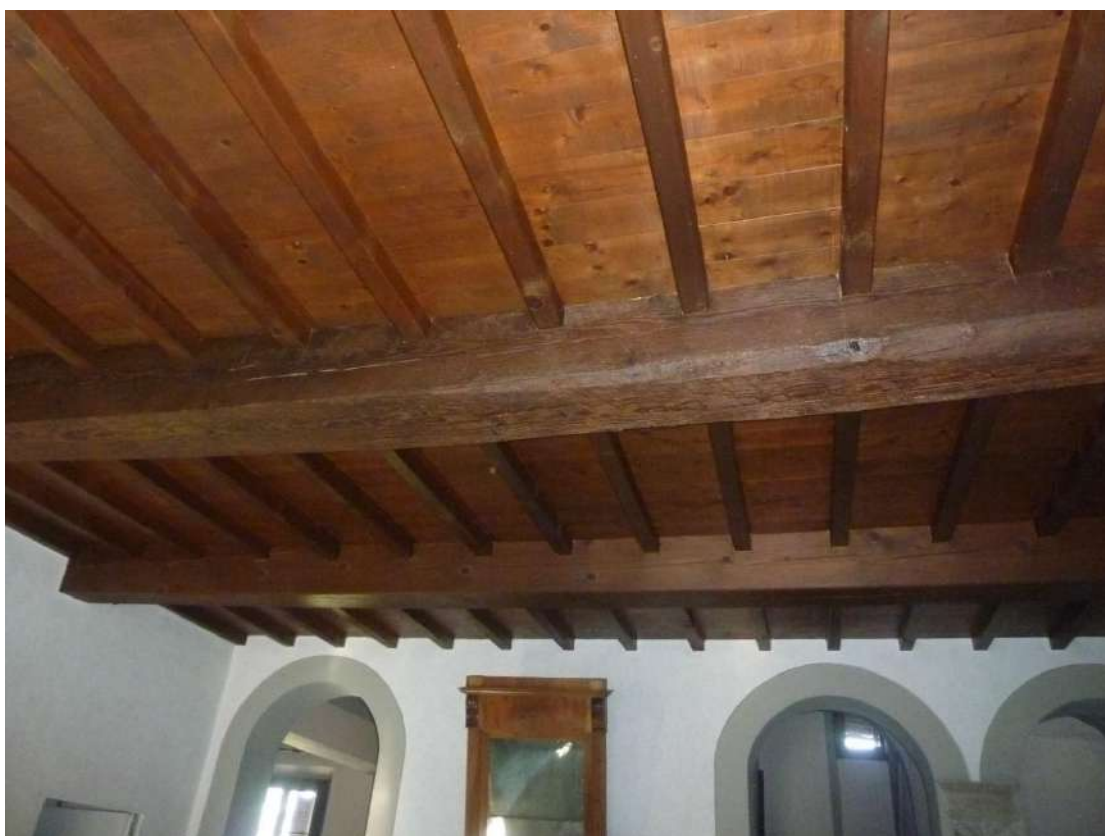
Foto 118: Villa – piano terra - ingresso centrale – soffitto
