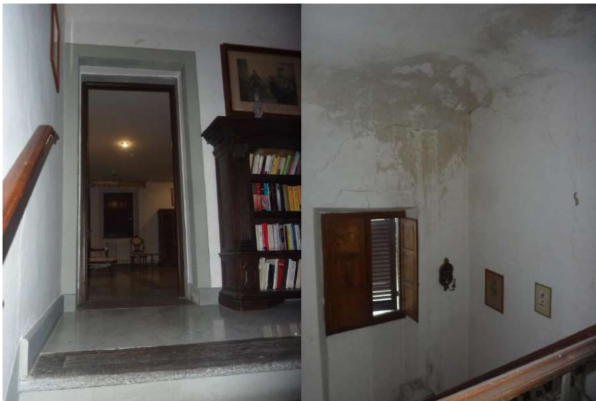
Foto 95: Villa – piano 1° - scala B – accesso al disimpegno centrale
