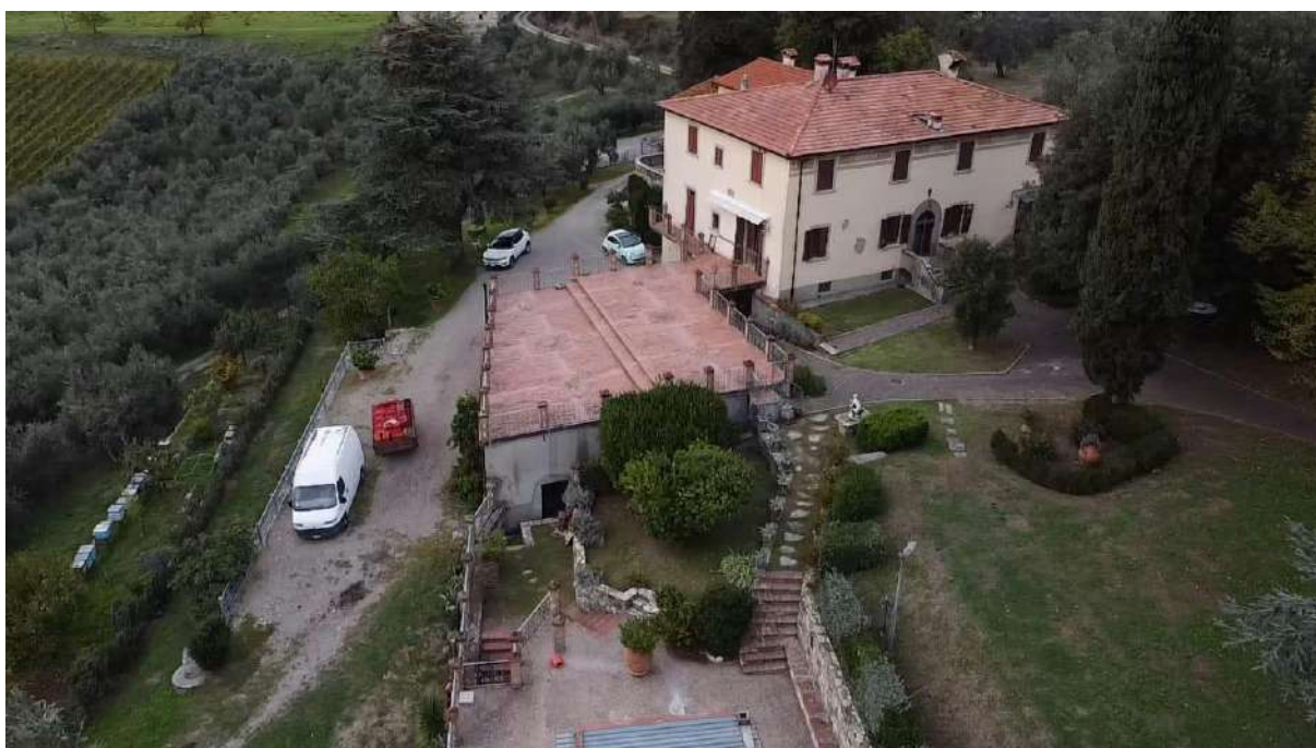
Foto 8: vista drone - villa/dépendance
