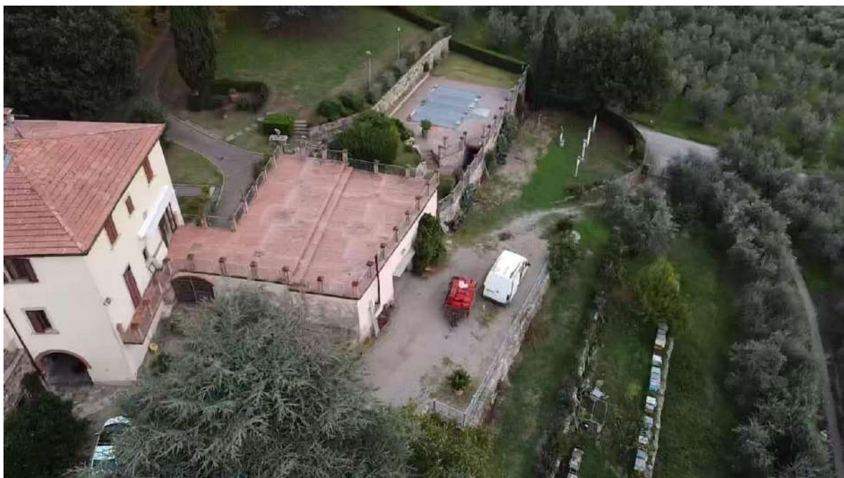
Foto 7: vista drone - villa/dépendance
