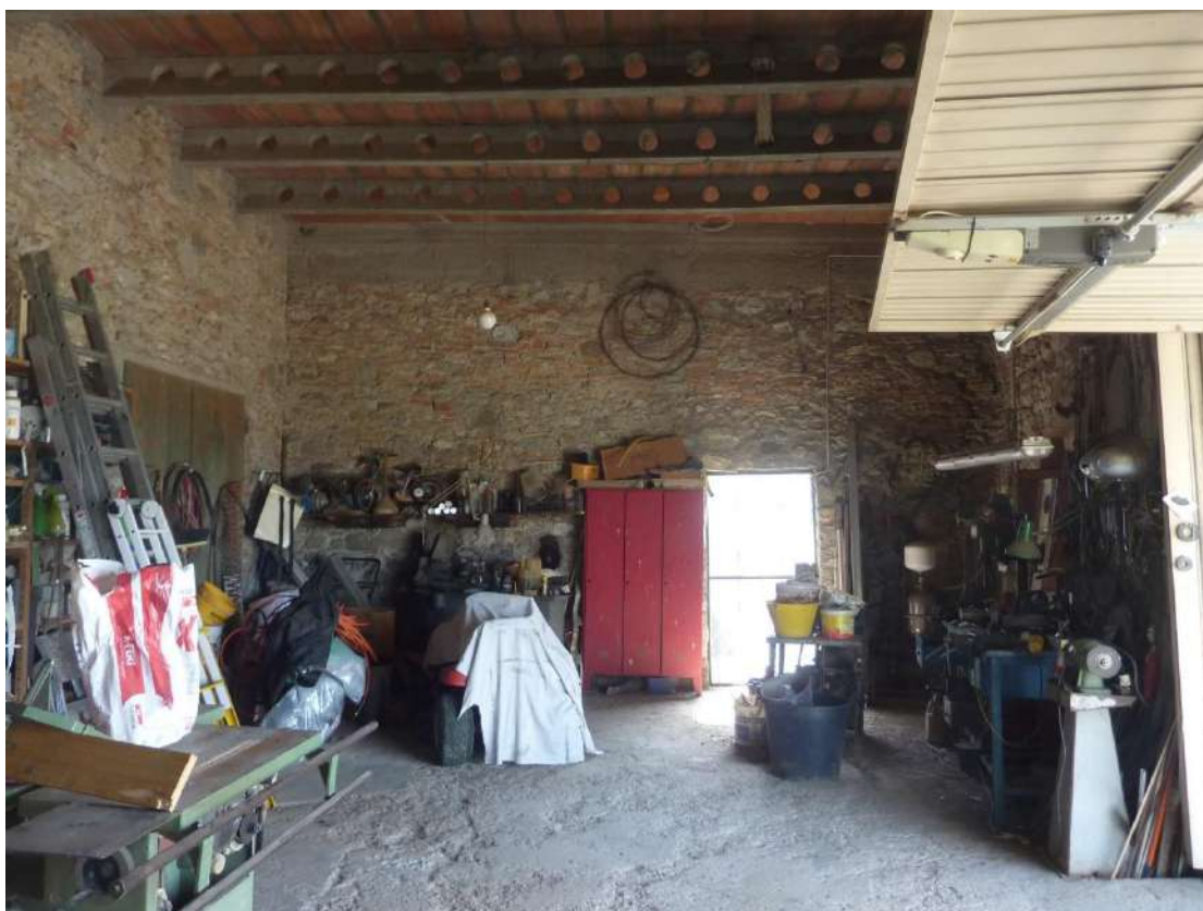
Foto 144: Villa – piano seminterrato 2° - deposito – accesso scannafosso
