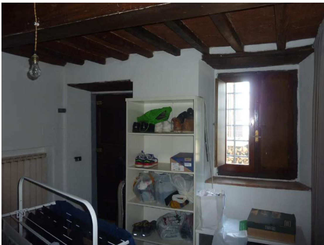
Foto 160: Dépendance – piano terra – disimpegno – accesso a scala B della villa
