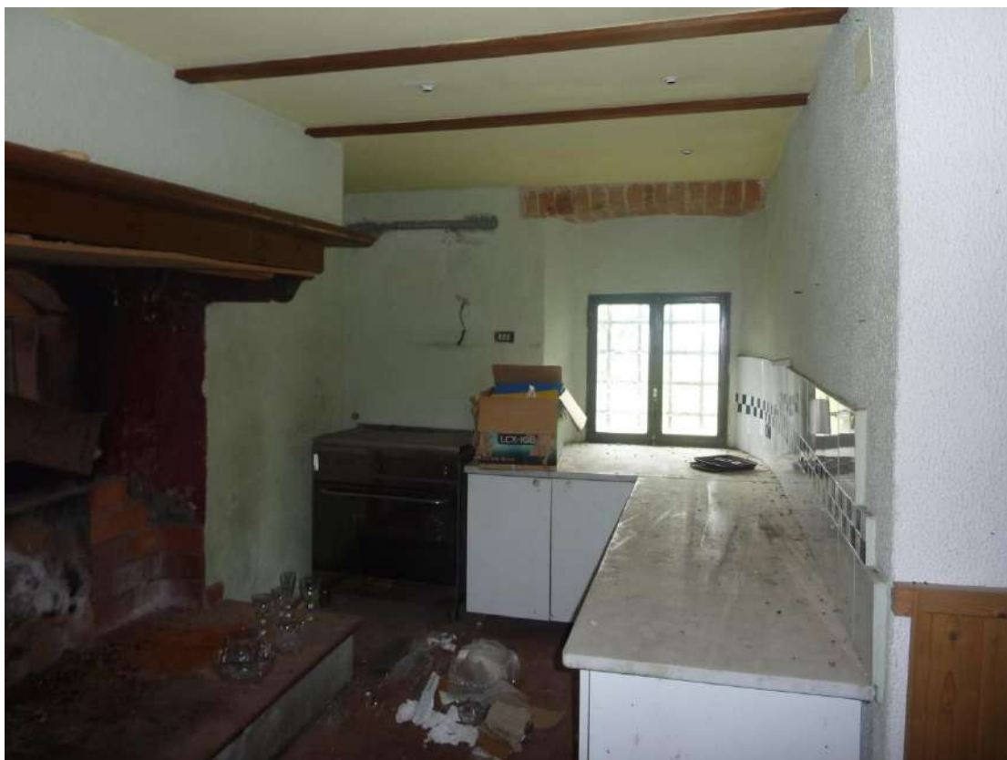
Foto 39: Casa colonica – piano terra – cucina
