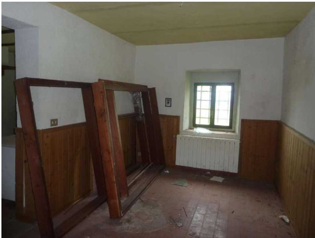
Foto 43: Casa colonica – piano terra – dispensa
