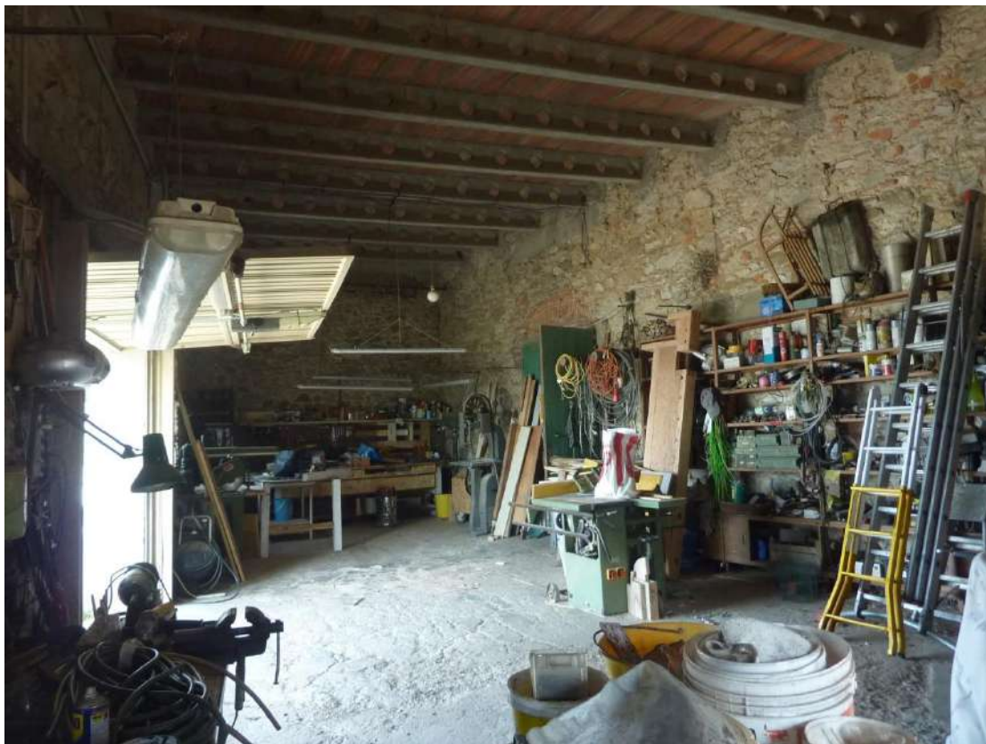
Foto 143: Villa – piano seminterrato 2° - deposito – accesso tinaia
