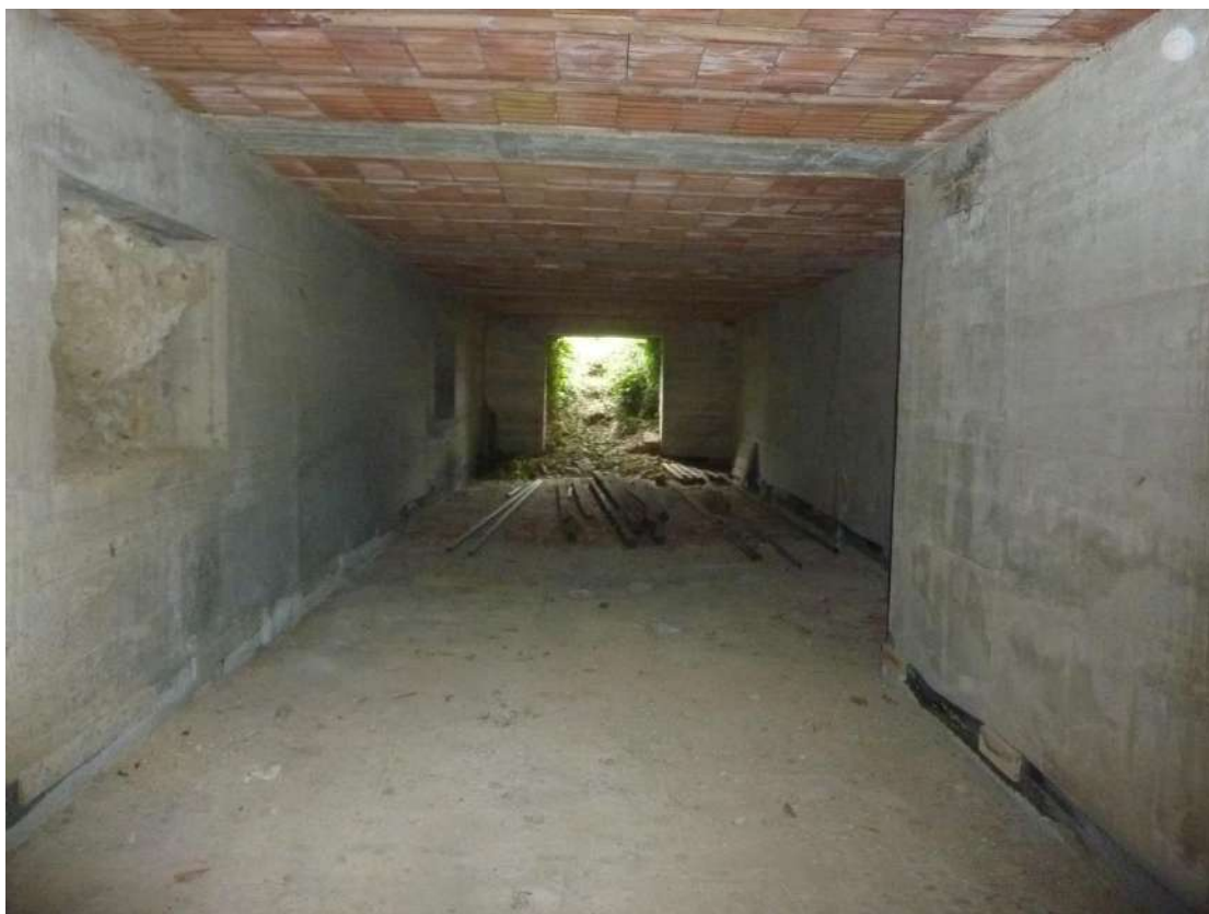
Foto 29: Casa colonica – piano seminterrato – cantina
