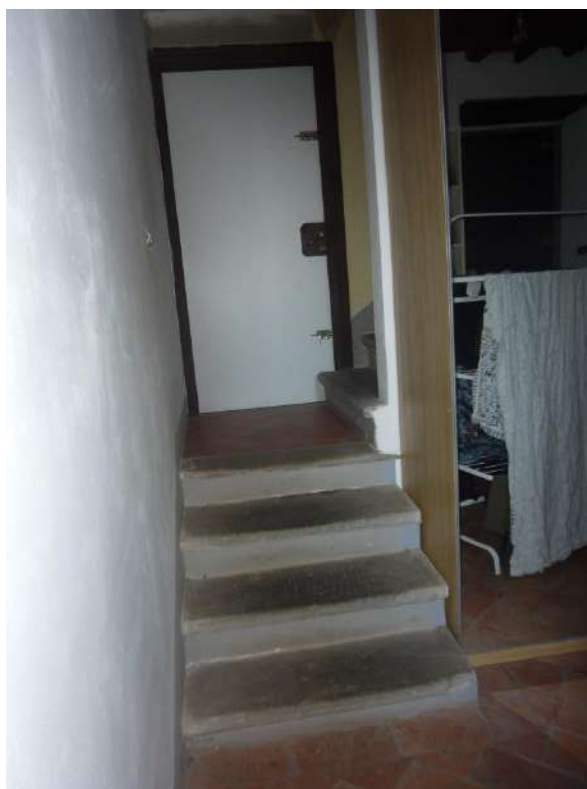
Foto 158: Dépendance – piano terra – scala A – collegamento tra piano terra e 1°
