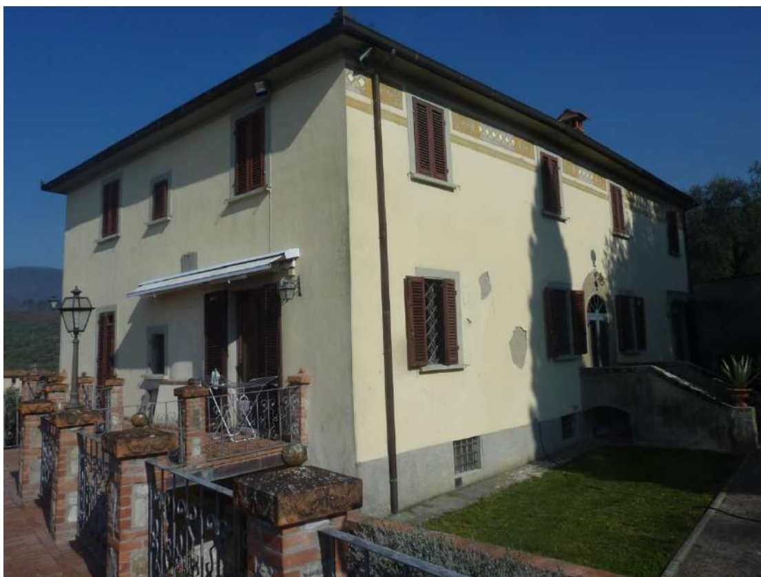
Foto 28: Villa – accesso laterale al piano terra rialzato
