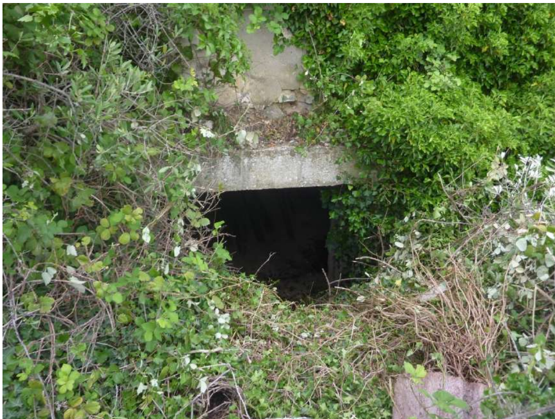
Foto 27: Casa colonica – piano seminterrato – accesso cantina
