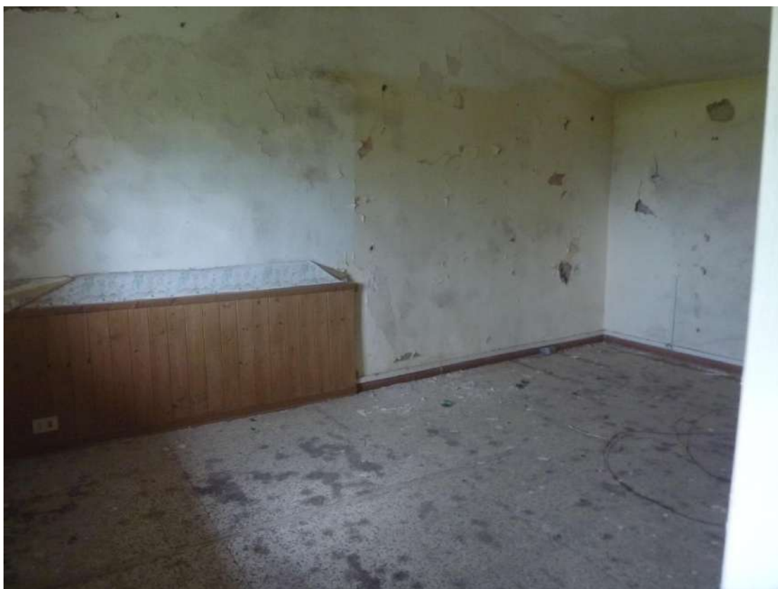
Foto 36: Casa colonica – piano primo – camera Nord
