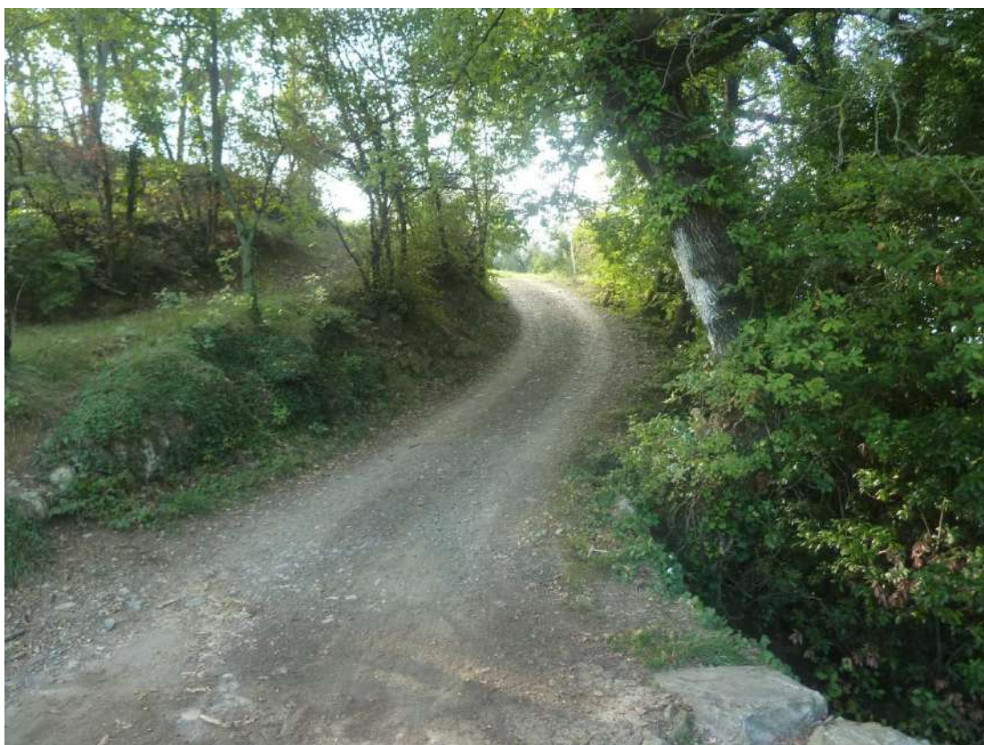
Foto 20: Terreni sopra strada: Via di Cicignano incrocio Fosso Funandola – sguardo verso la Rocca di Montemurlo
