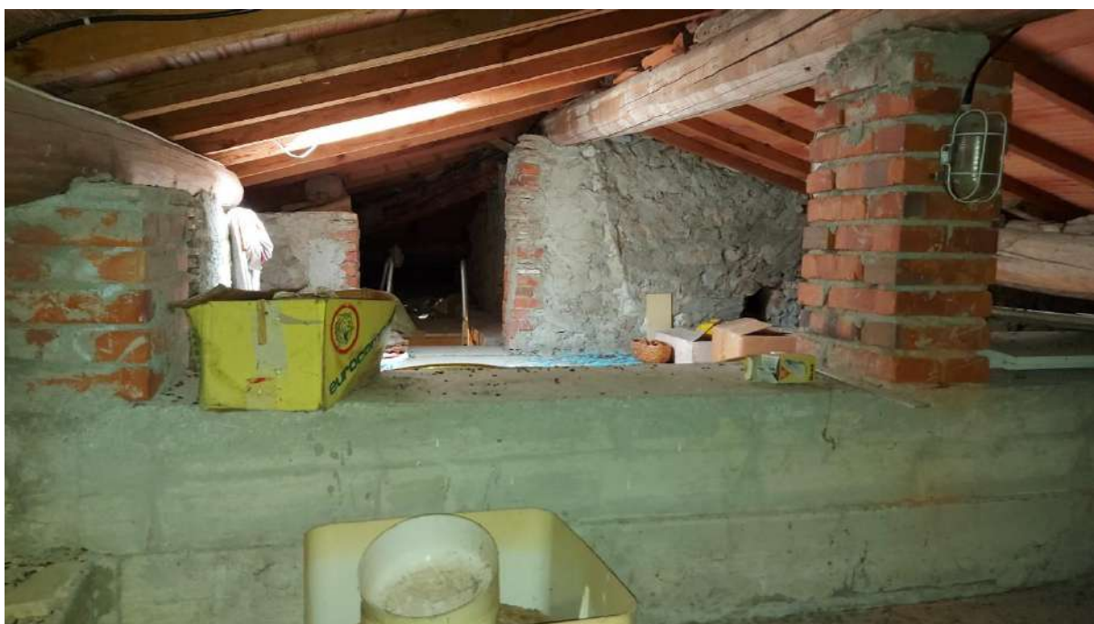
Foto 72: Villa – piano 2° - soffitta
