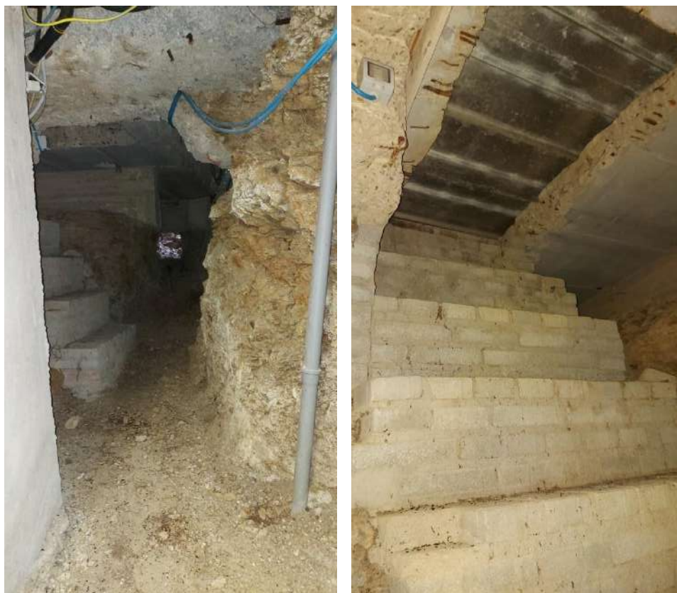
Foto 69: Scale di accesso alla loggia della dépendance
