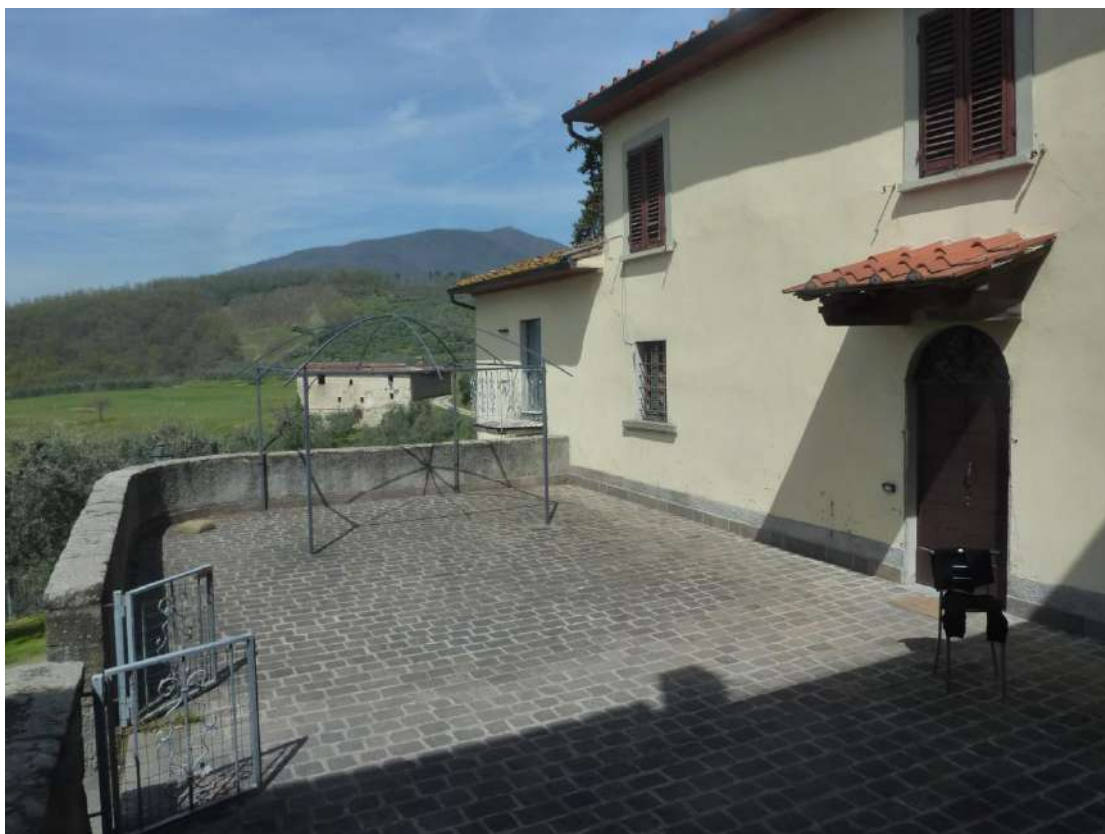
Foto 173: Dépendance – piano terra – terrazza
