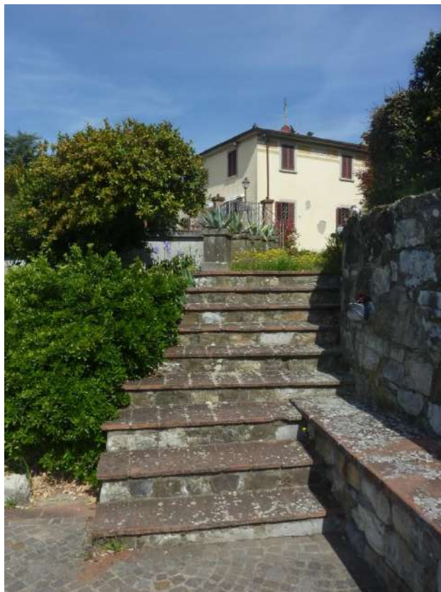
Foto 37: Villa – accesso alla piscina
