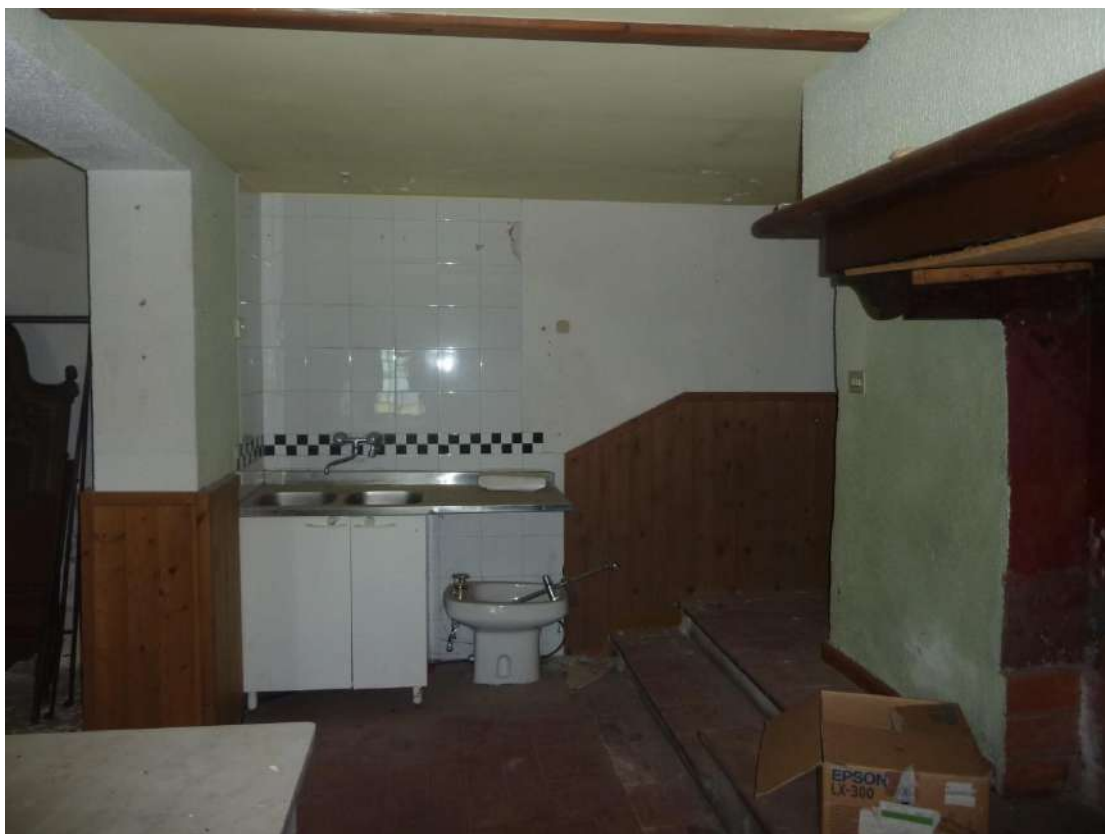
Foto 41: Casa colonica – piano terra – cucina
