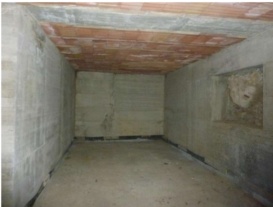
Foto 30: Casa colonica – piano seminterrato – cantina
