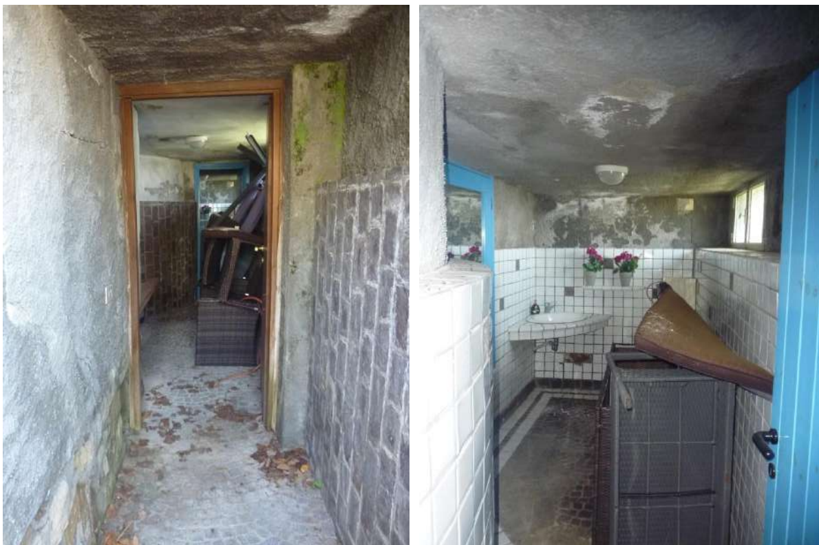
Foto 45: Villa – servizi della piscina
