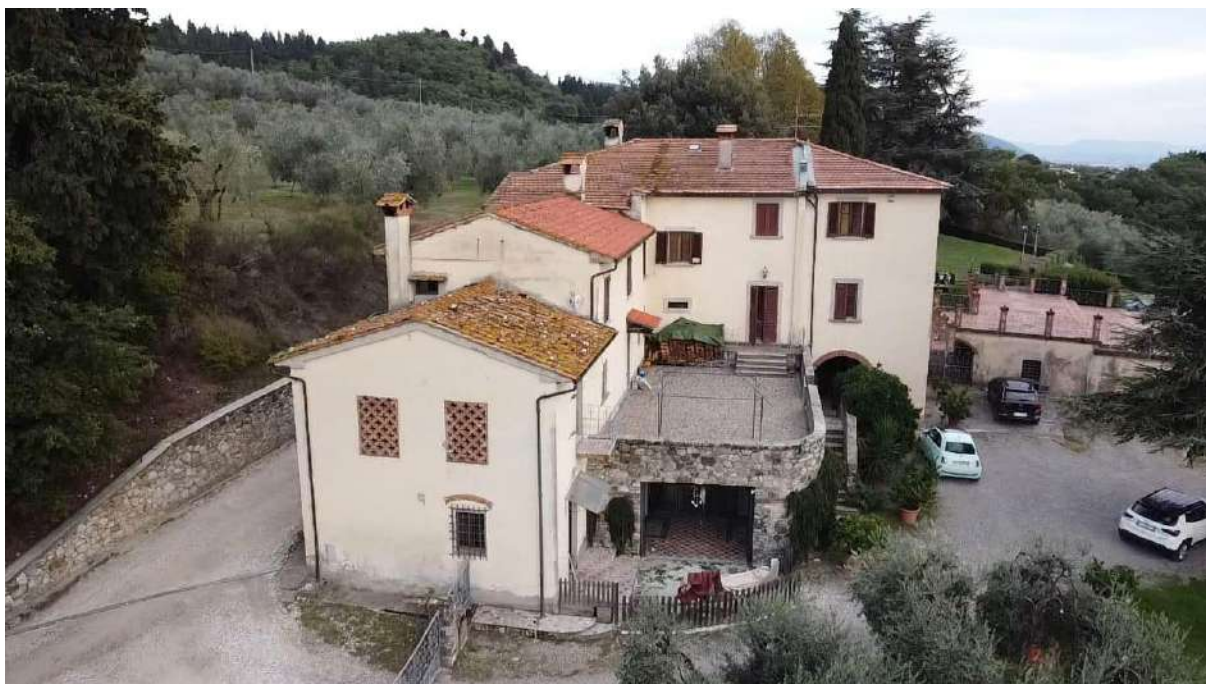
Foto 11: vista drone - villa/dépendance
