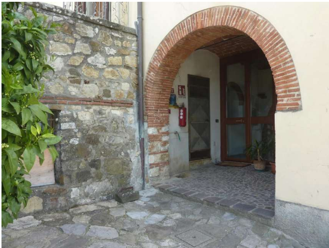
Foto 139: Villa – piano seminterrato 1° – loggia
