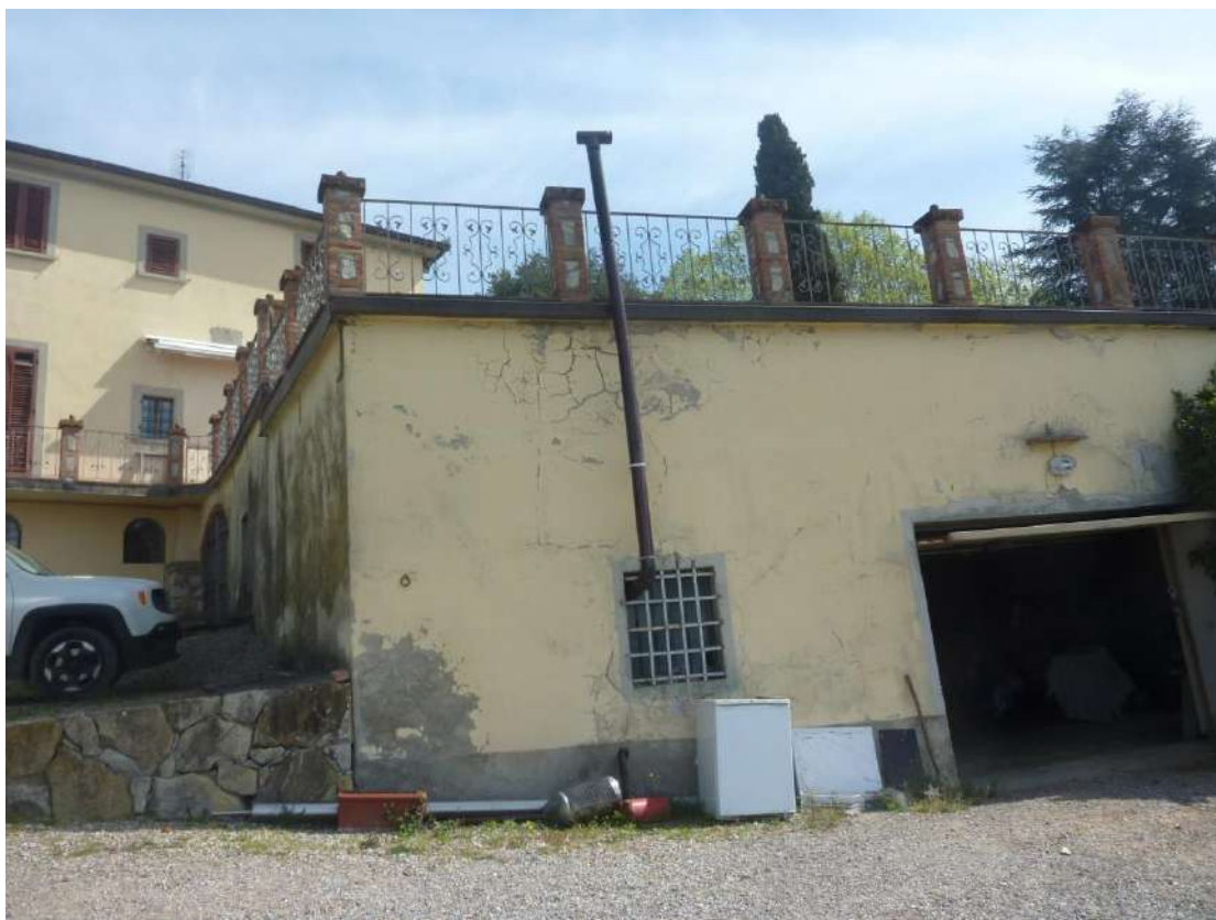
Foto 47: Villa – accesso al deposito seminterrato 2°
