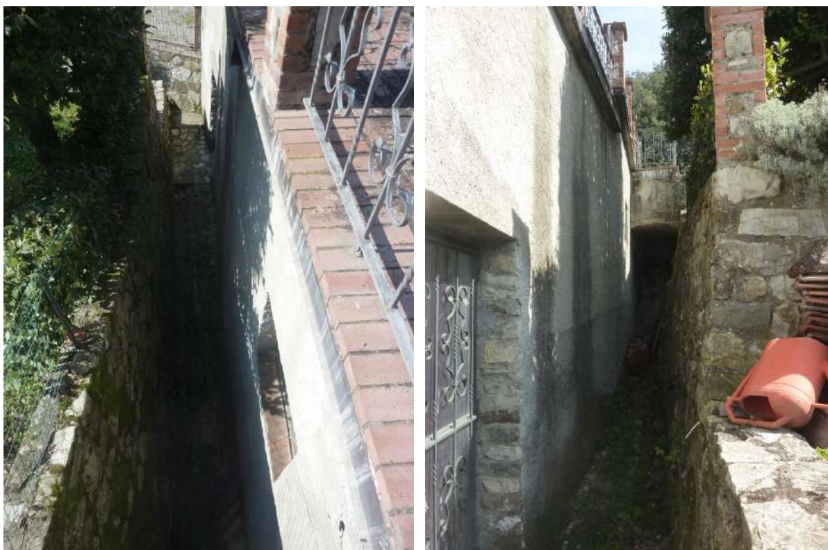
Foto 42: Villa – scannafosso tra terrazza e piscina – accesso al deposito seminterrato 2°
