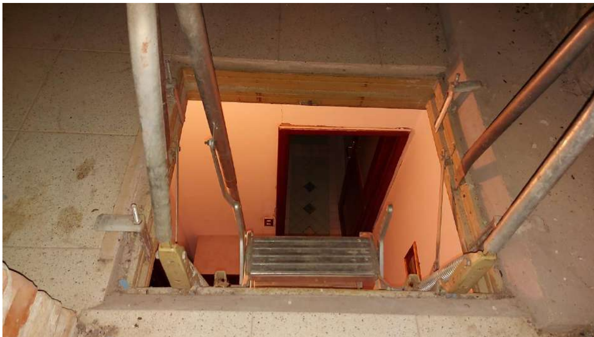
Foto 73: Villa – piano 2° - accesso alla soffitta
