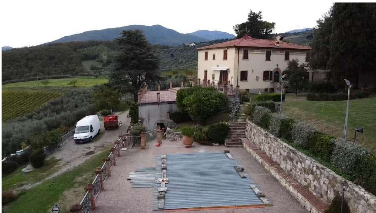
Foto 9: vista drone - villa/dépendance
