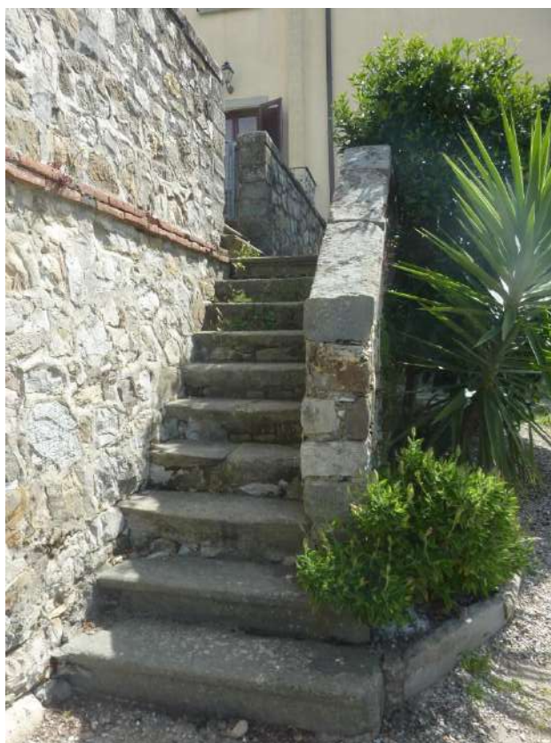
Foto 58: Villa/dépendance – accesso al piano terra della dépendance
