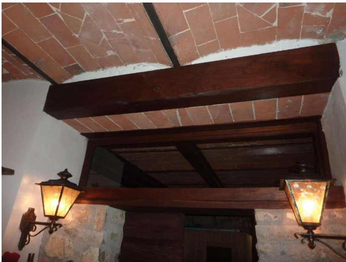
Foto 125: Villa – piano seminterrato 1° – camera – accesso a spa
