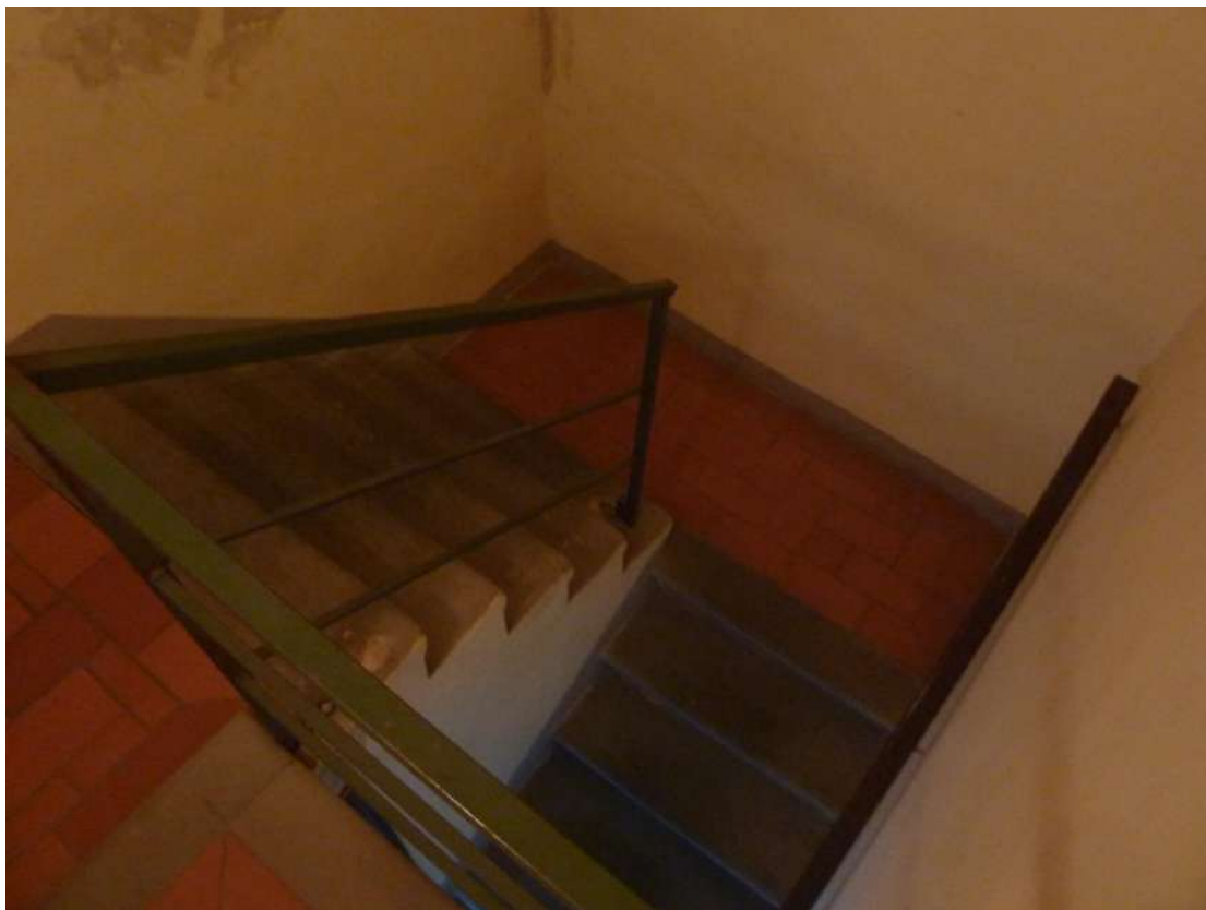
Foto 157: Dépendance – piano primo – scala A – collegamento tra piano 1° e terra
