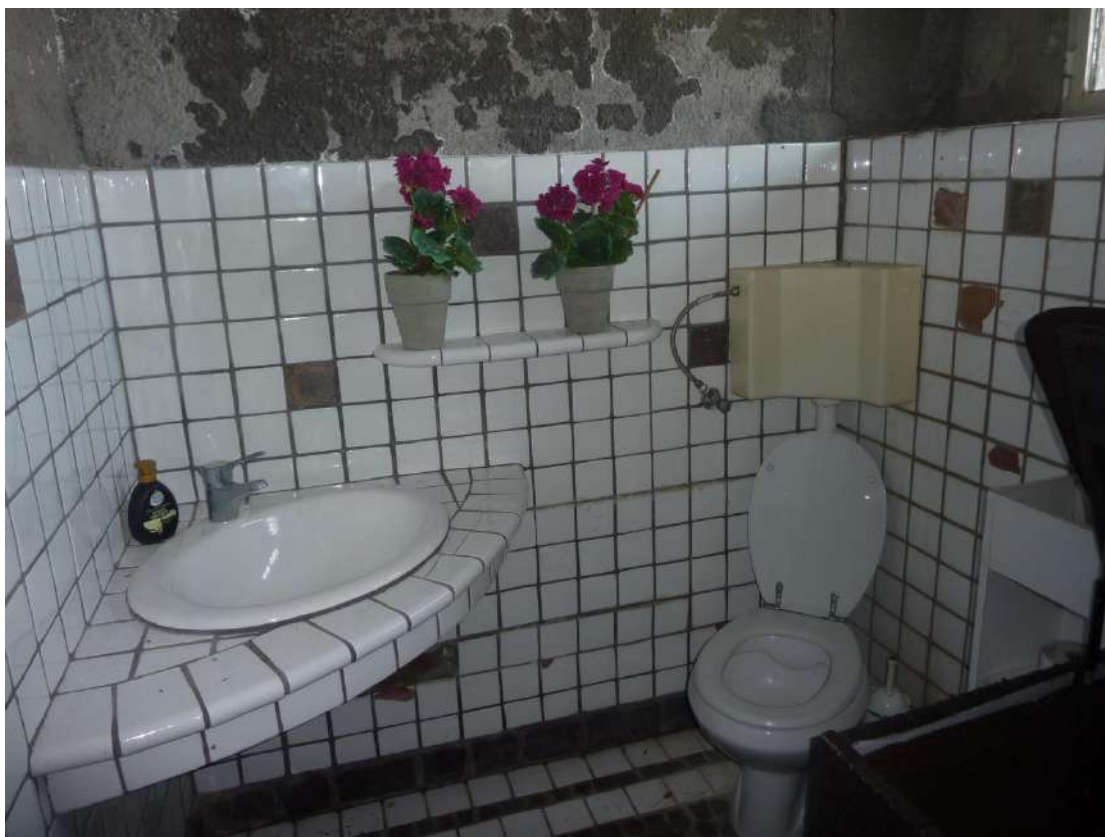
Foto 46: Villa – servizi della piscina
