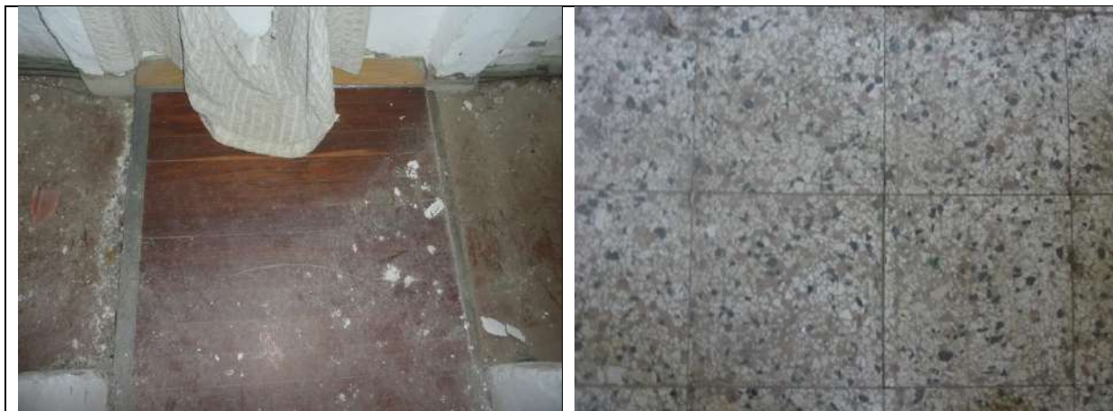
Foto 51: Pavimenti esterni e interni
