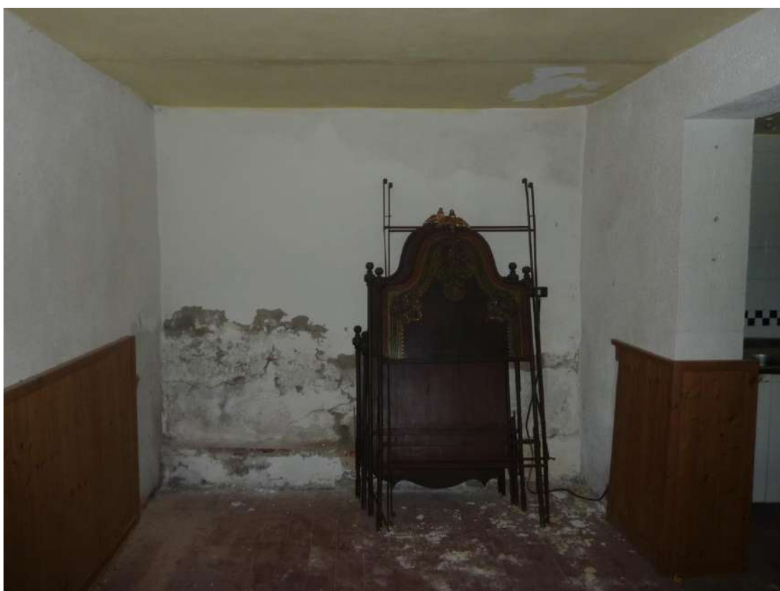
Foto 42: Casa colonica – piano terra – dispensa
