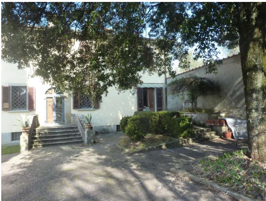
Foto 23: Villa – accessi al salone d'ingresso ed alla cucina di piano terra
